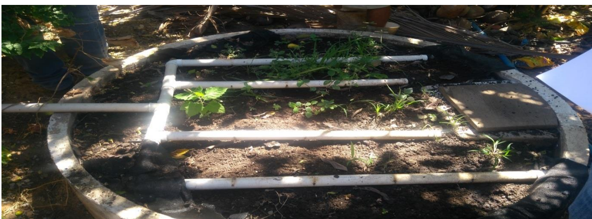
Figura6: Filtro de reutilização de água para irrigação. Acervo Pessoal.
